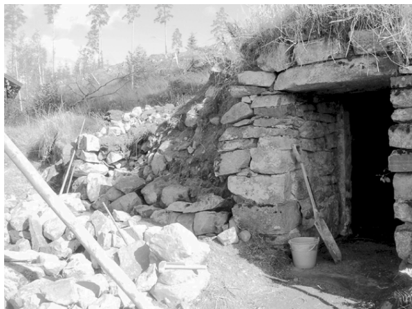
Jordkällare av typen överliggande stenhäll under renovering.
